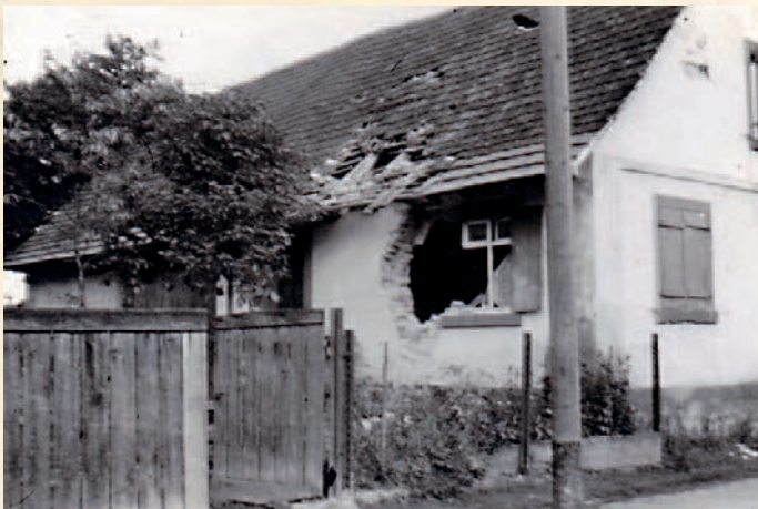
Zerstörtes Wohnhaus in Grafenhausen.
