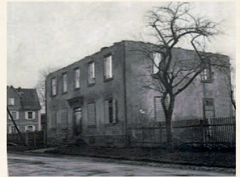
Das zerstörte Pfarrhaus.
