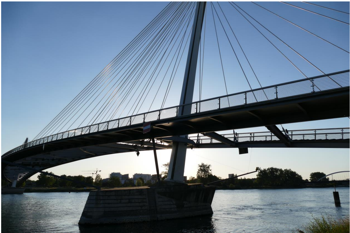
Passerelle am Zweifergarten - erbaut 2004 zur grenzüberschreitenden Landesgartenschau
